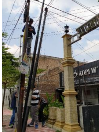
Gambar 4. Pemasangan tiang jaringan WiFi di RW 1 yang bertujuan mendukung alur distribusi internet ke kelurahan gendongan
